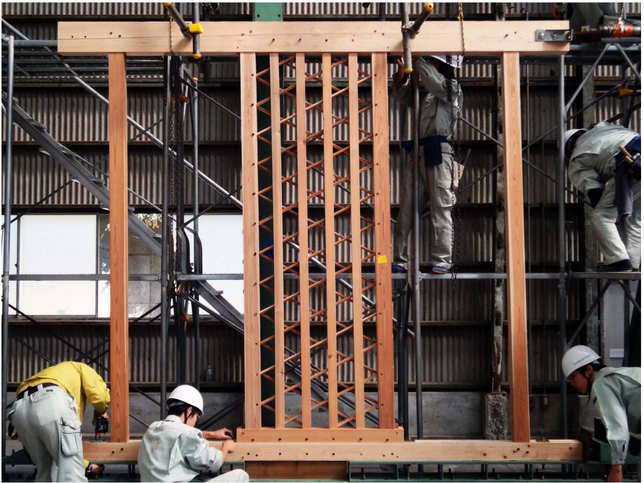
載荷実験の状況
